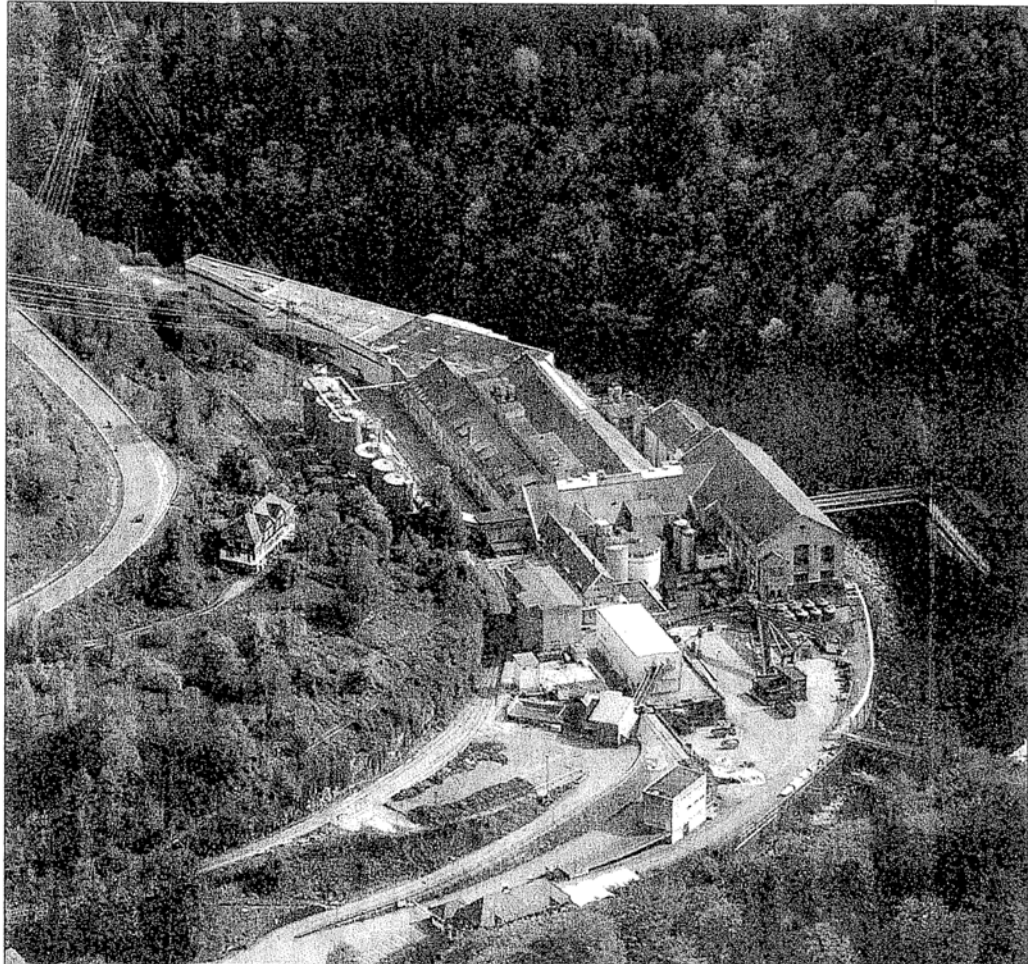
DIE ALTE PAPIERFABRIK WOLFSHECK soll in einen Gewerbepark umgewandelt werden. Eigentümer Günther Karl und die Gemeinde Forbach wollen an einem Strang ziehen. Luftbild: Hertweck
